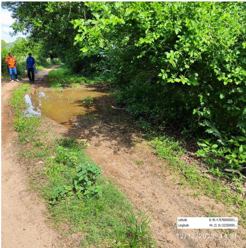
Local alagado pelas cheias do rio Gurguéia.
